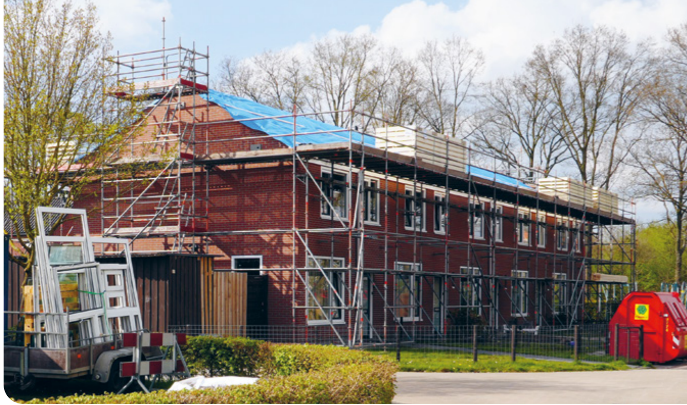
Nieuwe kozijnen voor een energiezuinige woning.
